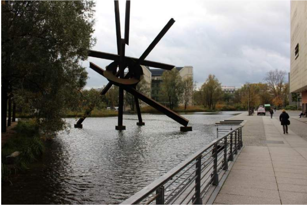
40. ábra: Vízgyűjtő medence, amely a környező sűrű beépítés tetővizét gyűjti, tisztítja és párologtatja
