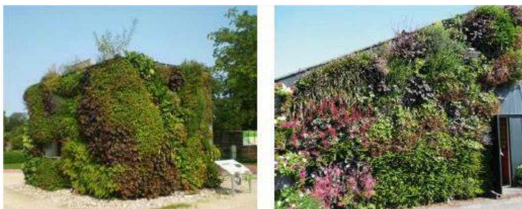
24. ábra: Függőleges gyökérzónás filces rendszer
