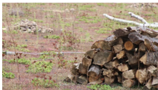
Ekstenzivni zeleni krov s drvenim i kamenim šipovima kao dodatnom pomoći za gnežđenje (© BUKEA)
